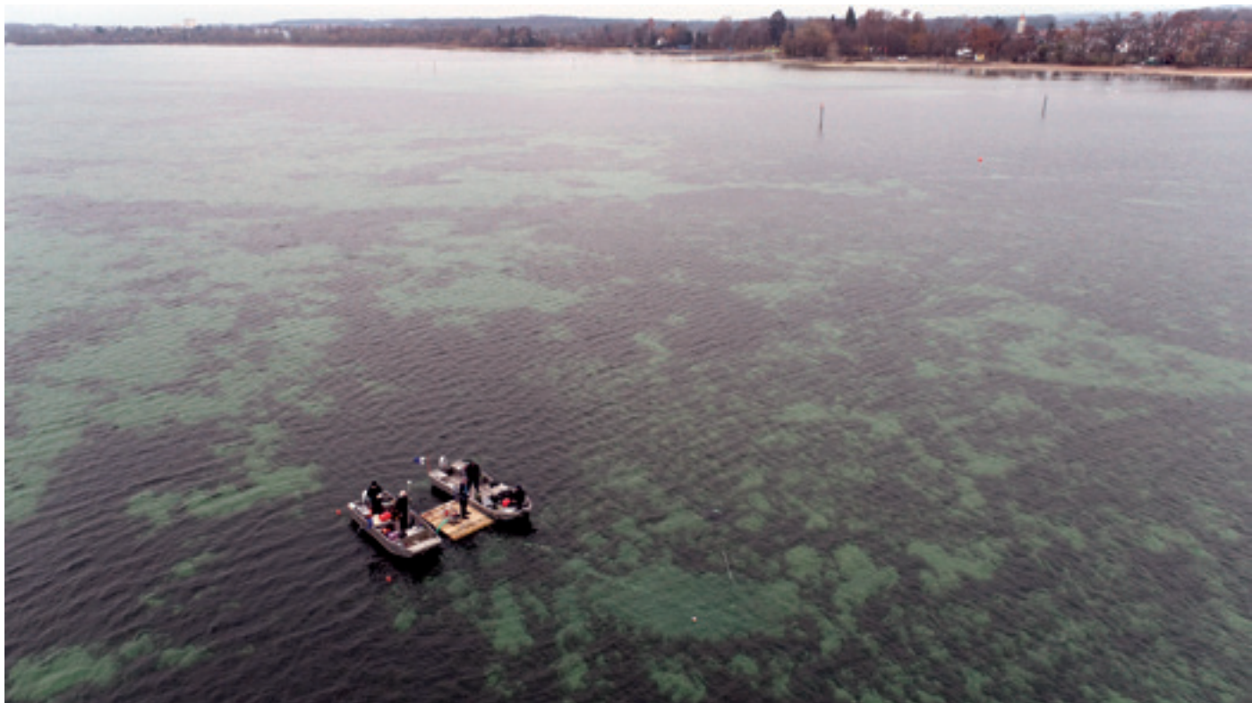
Manzell-Zeppelinhalle 2022. Arbeitsboote und Pumpenfloß über der Arbeitsstelle unter Wasser Manzell Zeppelin Hall 2022. Work boats and pump raft above the underwater workstation.
