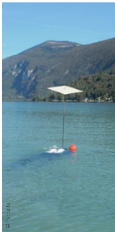
Installation des cibles pour le géoréférencement des clichés drone. Installation of targets for georeferencing of drone images.
